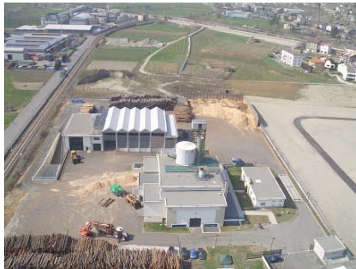
•Impianto di Tirano
